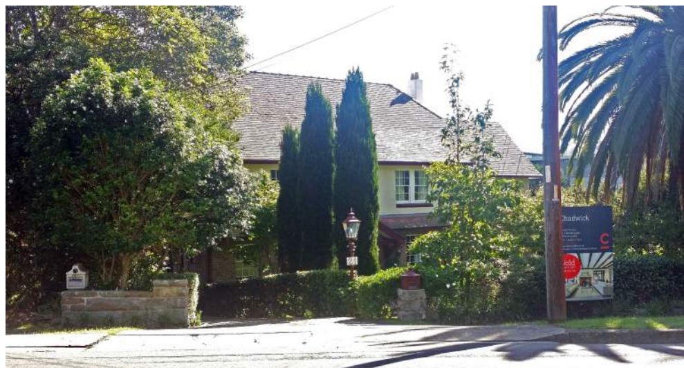
21 LORNE AVENUE (SUBJECT SITE)
